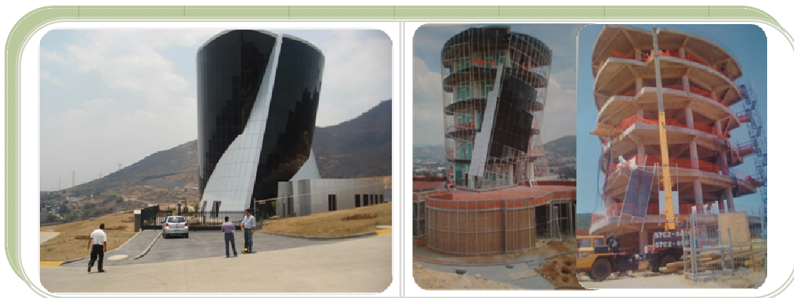
Fotografía correspondiente a la obra 4
