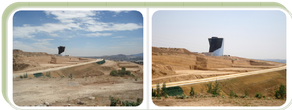
Fotografía correspondiente a la obra 6
