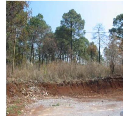
Construcción de cafetería
